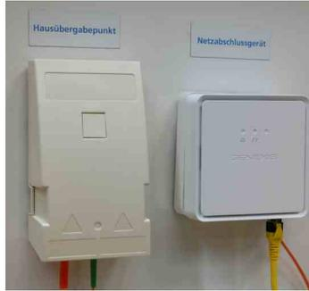
Diese Komponenten kommen von Deutsche Glasfaser kostenlos ins Haus. Der Hausübergabepunkt (links) wird in der Nähe der Hauseinführung des Glasfaserkabels montiert und das Netzabschlussgerät (rechts) kann per Glasfaserkabel bis zu 20 Meter abgesetzt werden – beispielsweise direkt in die jeweilige Wohnung in der Nähe des Routers.
